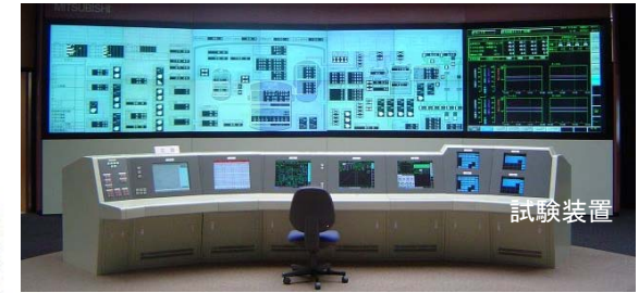
新型中央制御盤
